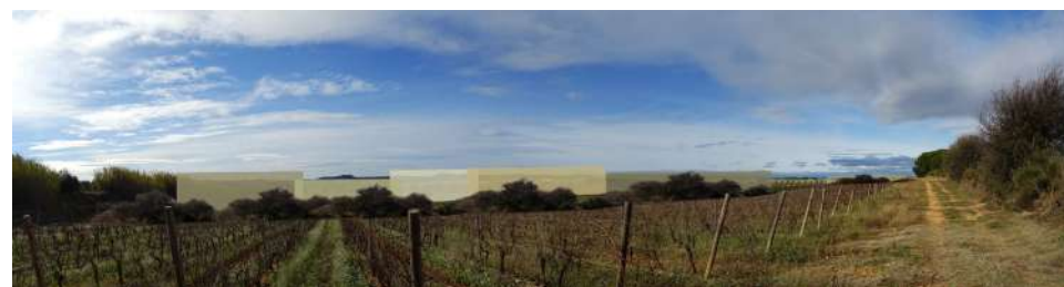
Illustration 21. Vue depuis le sud-ouest
