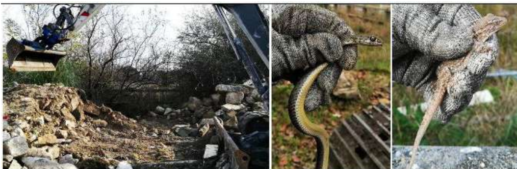
Exemple d'intervention effectuée par CBE en 2018 : décapage à l'aide d'une pelle mécanique, capture d'une Couleuvre de Montpellier et d'une tarente de Maurétanie
