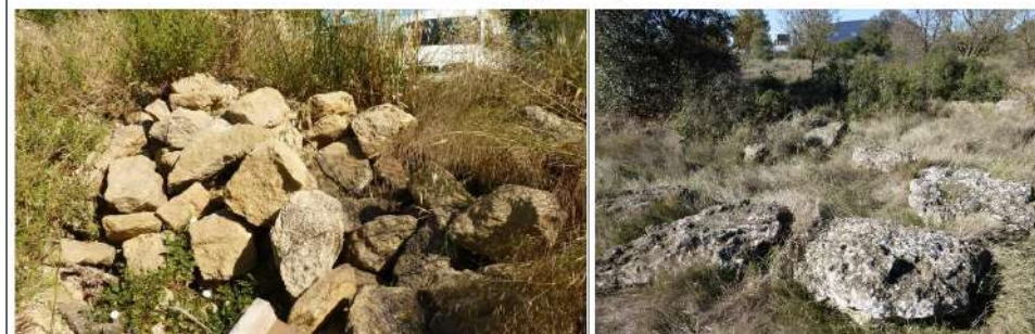
Exemples de gîtes à reptiles devant être évacués de l'emprise du projet en étant accompagné d'un écologue – CBE, 2017
