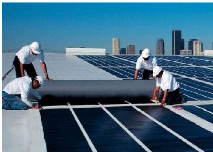
Mise en place de membrane photovoltaïque (Source : Solaris energy)
