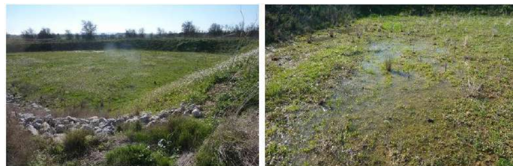
Bassin de rétention avec une fine lame d'eau en février – CBE, 2017
