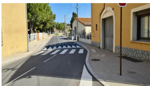
Sécurisation passage piéton
